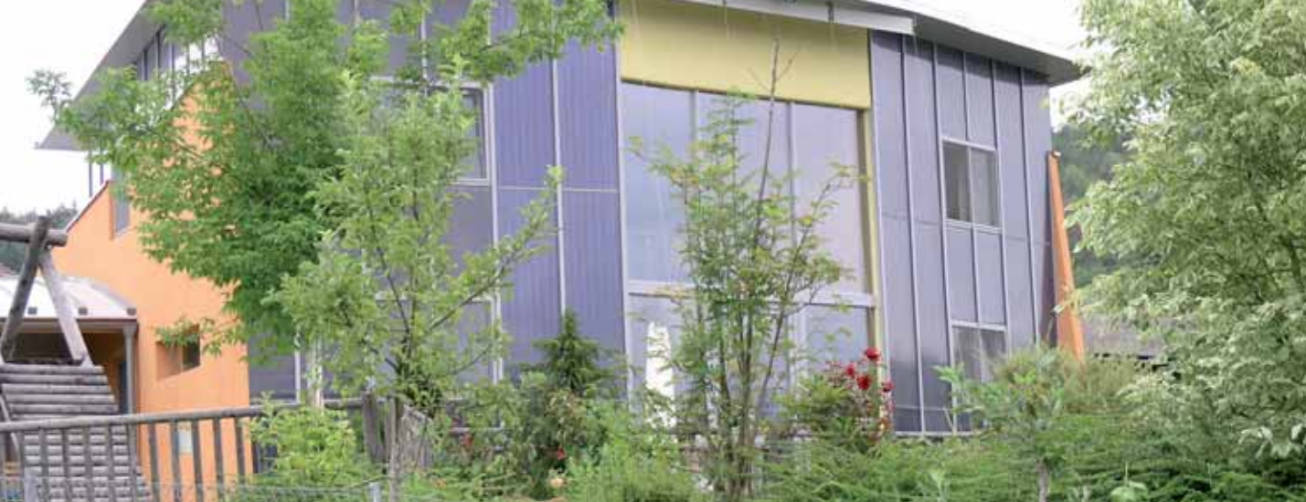
Slika 23: Orientacija zgradbe proti jugu daje konceptu zgradbe precej ugodnosti z velikimi zastekljenimi površinami in vključevanjem sprejemnikov sončne energije. Južna fasada je zalomljena proti vzhodu in zahodu, kar omogoča še večji izkoristek, enodružinska pasivna hiša, Škofiče pri Vrbskem jezeru, Avstrija.
