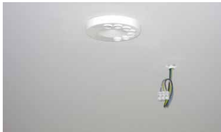
Slika 128: Razvod dovodnega zraka na stropu (levo), vpihovalna šoba za usmerjanje dovoda zraka na stropu
