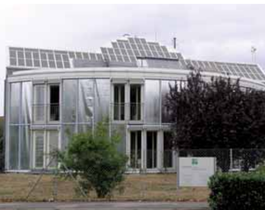
Slika 24: Orientacija proti jugu in krožna zasnova zgradbe omogočata izrabo sončne energije z uporabo zastekljenih površin, prosojne toplotne izolacije, sprejemnikov sončne energije in sončnih celic, energijsko samozadostna hiša, Freiburg, Nemčija.
