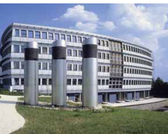
Slika 6: Energon v Ulmu je največja pasivna poslovna stavba na svetu (7000 m 2 notranjih površin). Zgradba je dobro toplotno izolirana (stene 35 cm, tla pod temeljno ploščo 20 cm, streha 50 cm toplotne izolacije). 40 % delež steklenih površin na fasadi omogoča optimalne dobitke sončnega obsevanja, kot sončna zaščita služijo lamele na mehanski pogon. 328 m 2 sončnih celic na strehi letno proizvede 12.000 kWh električne energije. 52
